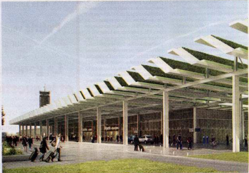
Toits végétalisés, paniers bios, jardins collectifs, culture maraîchère... À en croire le géant du BTP Vinci, ce n'est plus un aéroport, mais la plus grande ferme bio de France ! JACQUES FERRIER ARCHITECTURES/AFIP
